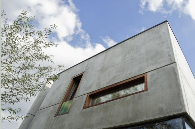
Afbeelding 2: Ramen bovenverdieping voorkant gebouw
